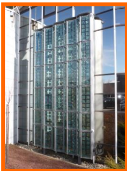
Figure 1 : exemple de paroi active et adaptative//double-peau ventilée photovoltaïque
