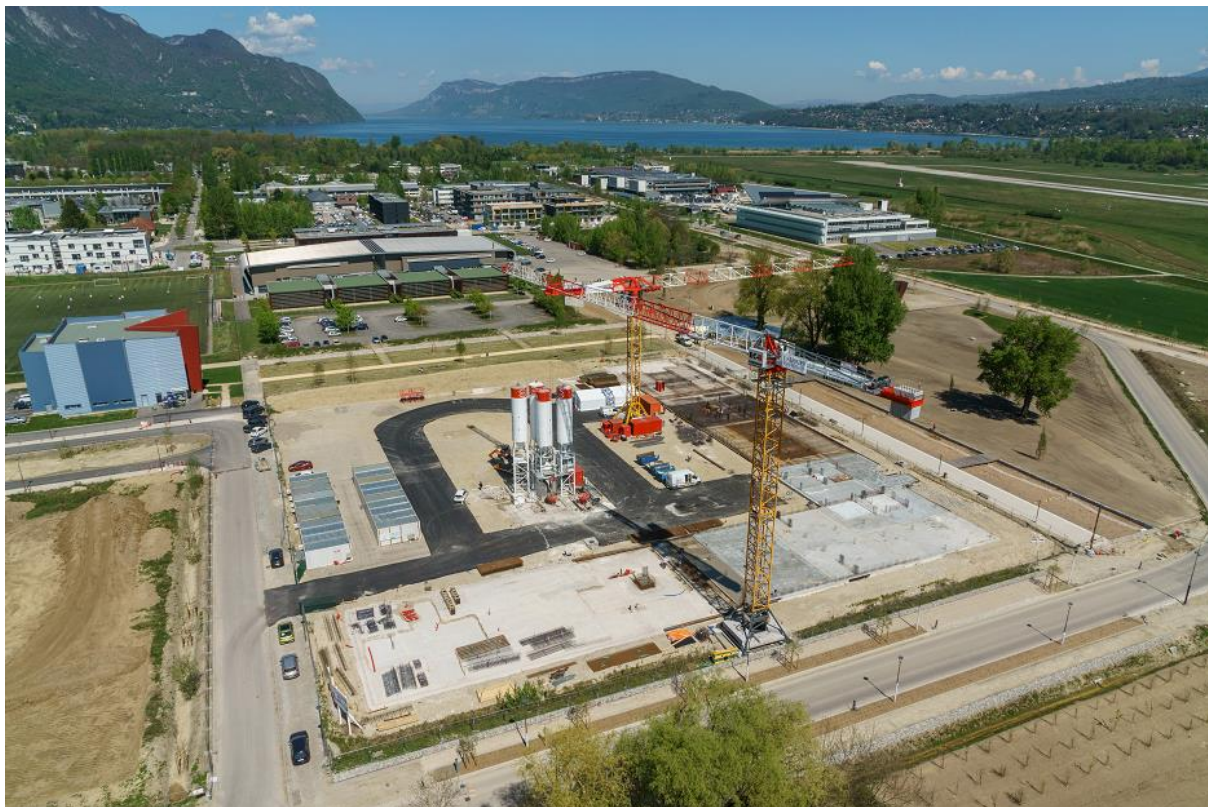
Chantier du bâtiment Etincelle (2017)
