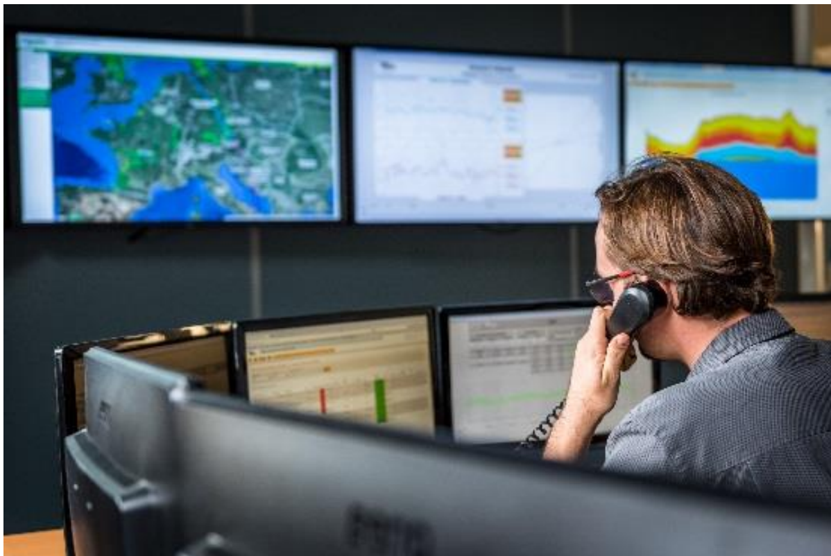
Le centre opérationnel d'Energy Pool
