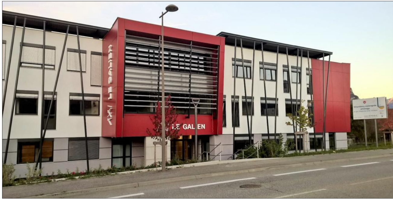
Le nouveau bâtiment Galien héberge le Centre d'évaluation et de prévention articulaire, une pépinière d'entreprises et un laboratoire de l'Université de Savoie. Photo Le DL/Gh.G.
